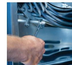
Dévisser l'écrou-raccord du gicleur (dans la direction inverse des aiguilles d'une montre – ouverture de clé : 15).
